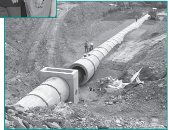
El Grupo de Tuberías del Noreste usó 15,000 pies de tubería de concreto reenforcada y tomó en consideración cambios geológicos, que aflojan los niveles bajos de tierra y rocas. Con el Departamento de Transporte de Pennsylvania, el Grupo construyó un terraplén positivo colocando los arroyos 60 pies por debajo de la carretera terminada en una manera de costo efectivo.
